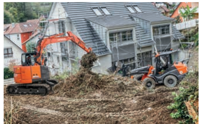
O raio de rotação curto faz da ZX85US-6 a máquina ideal para trabalhar em espaços apertados.
